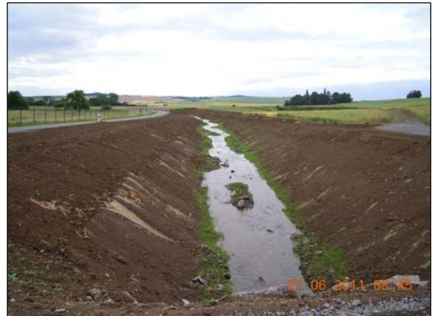
Der Gewässerausbau erstreckt sich auf 675m und beinhaltet 3 Duschlässe. Zudem wurden auf einer weiteren Strecke von 925m Renaturierungsmaßnahmen durchgeführt. Der Naturnahe Ausbau erfolgt durch den Rückbau von Betonhalbschalen und einer speziellen Profilausprägung.
